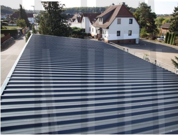
Auch bei den Schrauben für das Dachblech wird mit der Spannschnur so bei der Verschraubung verfahren.
