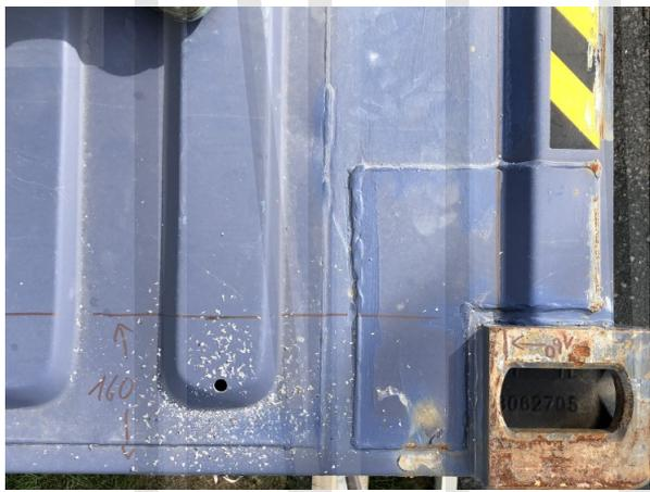
Löcher für die Gewindestangen zur Befestigung der Dachbalken => 38 St.
