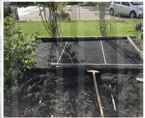
Der Frostschutz 0-32 wird verdichtet. Dann Rohre mit Gefälle verlegt, mit Splitt 0-5 aufgefüllt und mit einer Latte abgezogen. Auf diese Fläche werden die Steine gelegt.
