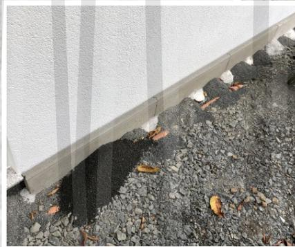
Auch am Haus entlang erfolgt ein Abschluss mit dünneren Platten. Zum Schutz für die Hauswand.
