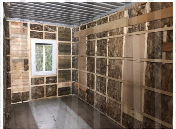
Um später Wandlampen, Schränke oder TV Wandbefestigungen nicht nur mit Hohlraumdübel für befestigen, werden einige Felder mit Holz gelattet. Das bedeutet mehr Stabilität!
