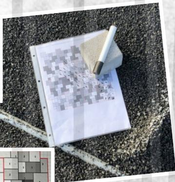
32 m<sup>2</sup> waren genau 4 Paletten, jede mit einem anderen Grauton. Betonsteine mit Basalt Deckschicht. Das Muster sollte noch sehr anspruchsvoll werden!
