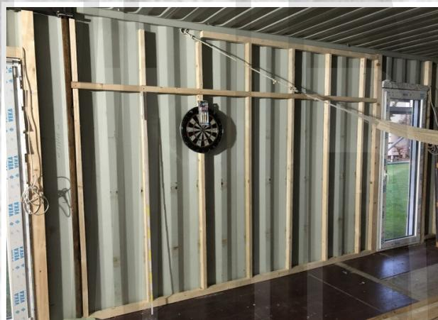
Der Wandaufbau besteht aus vertikalen 6 cm Längsstreben, die auf das Metall aufgeschraubt werden. Danach die vertikale Querlattung, die nicht bis an die Containerwand reicht.
