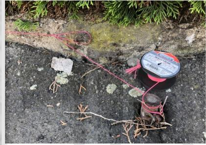
Zur Orientierung für Einbauhöhe und gerade Folge dient eine Richtschnur - hier an den Grenzsteinen befestigt.
