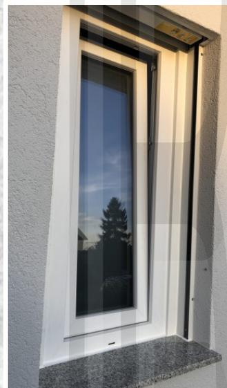
Die Fensterbänke haben eine glatte Oberfläche, bis auf die Exemplare, die mit Füßen betreten werden können. Hier ist die Oberfläche angeätzt - angeraut.
