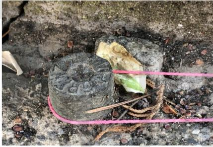
Bevor die Pflastersteine verlegt werden, muss zuerst die Einfassung erstellt werden.
